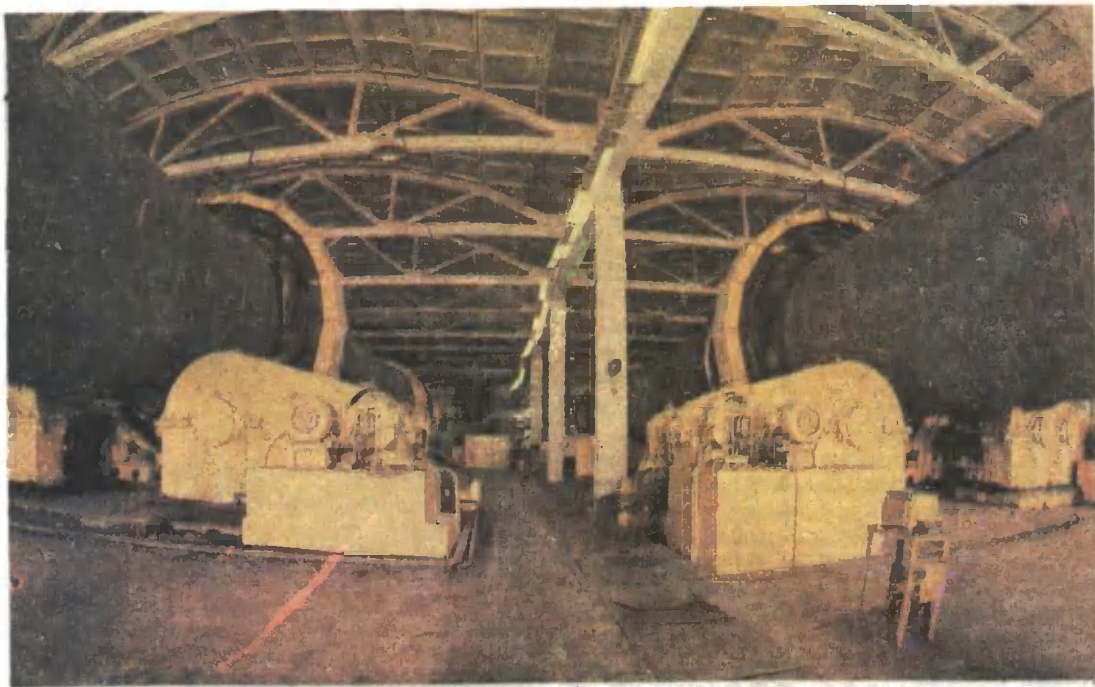
В корпусе биотермического компостирования Санкт-Петербургского завода по переработке твердых бытовых отходов. Этот завод функционирует с 1971 г.
